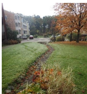
Lågstråk med dike för infiltration
