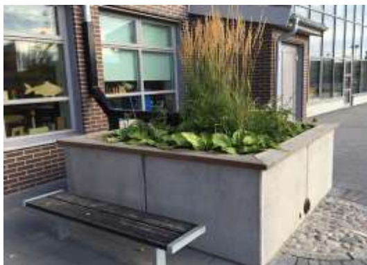
Figur 16 Exempel på upphöjd regnbädd för takvatten, källa Hekla regnbädd - Bara Mineraler
