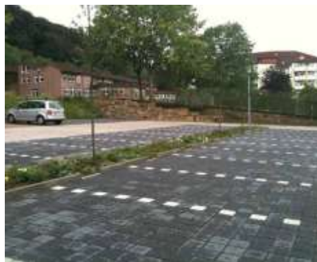
Figur 17 Exempel på nedsänkt dagvattenhantering vilken kräver ny höjdsättning, källa Uppsala Vatten
