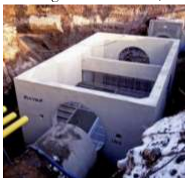
Figur 22. Exempel på prefabricerat filtermagasin
