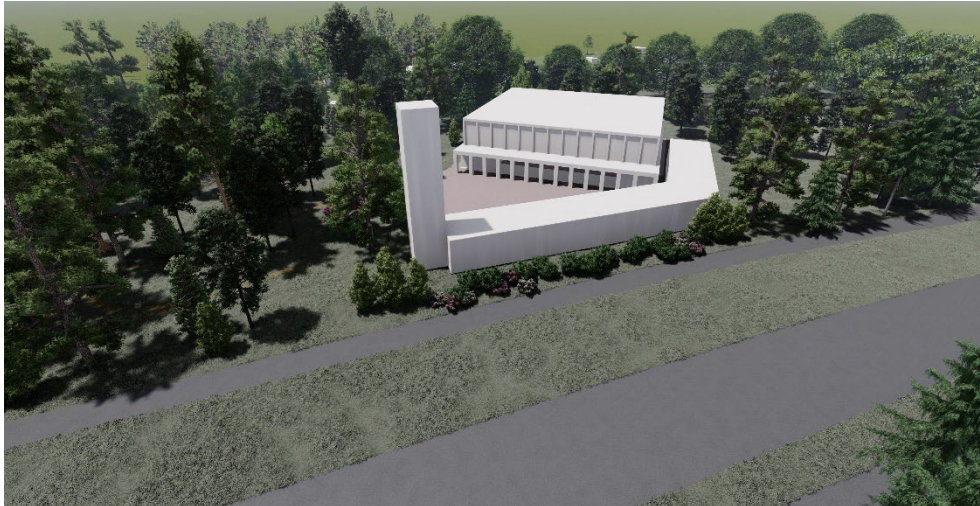
Visualisering av en möjlig utformning av framtida bebyggelse inom södra kvartersmarken med blick från Norrlidsvägen mot öster
