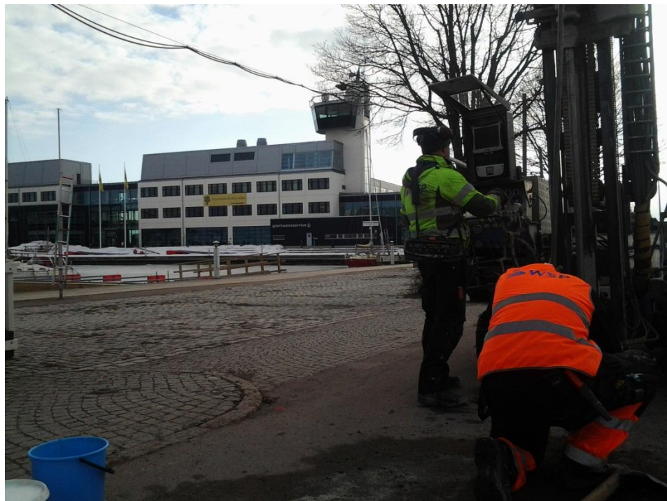
Figur 4: Vy mot sydost från GC-väg längs Ölandskajen.
