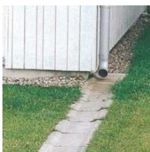
Utkastare till ränna/gräsmatta
